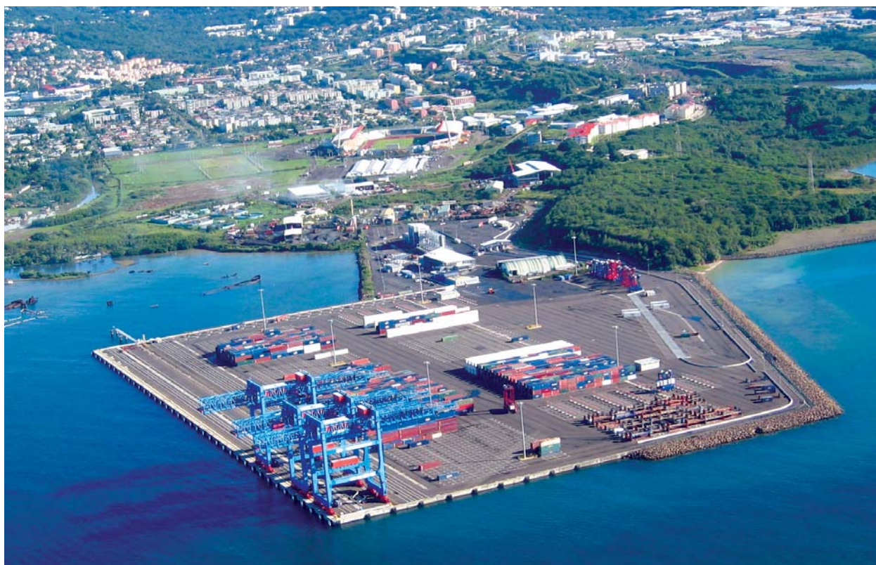
Martinique, installations portuaires pour le chargement des containers de bananes à Fort-de-France.
